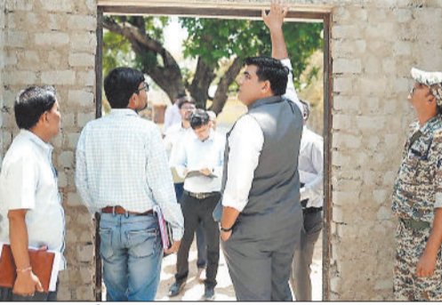
निर्माण कार्य का निरीक्षण करते कलेक्टर एवं अन्य।
